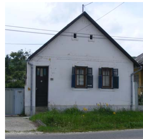
Homlokzati vakolatdíszek, zsalugáteres ablakok, harmonikus nyílásrend
