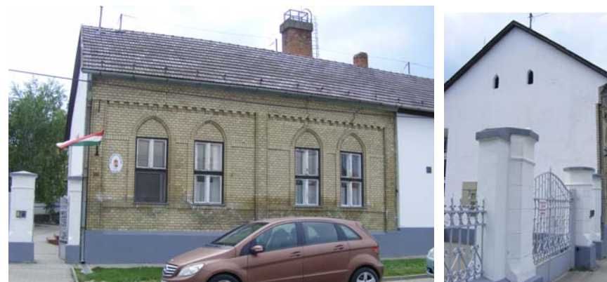
Az általános iskola téglarchitektúrárs épülete
