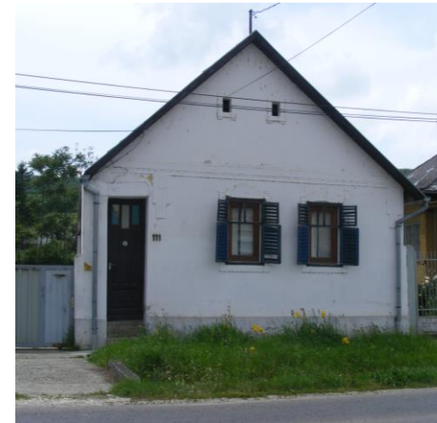
Homlokzati vakolatdíszek, zsalugáteres ablakok, harmonikus nyílásrend
