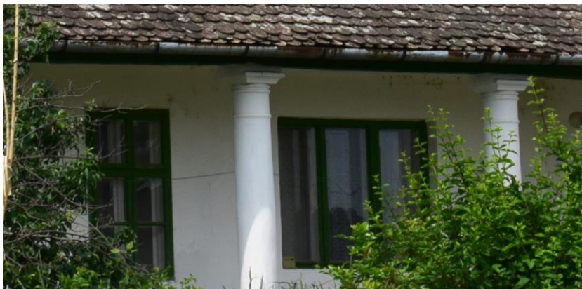
Udvari tornác falazott, vakolt felületű, fejezetes tornácoszlopokkal
